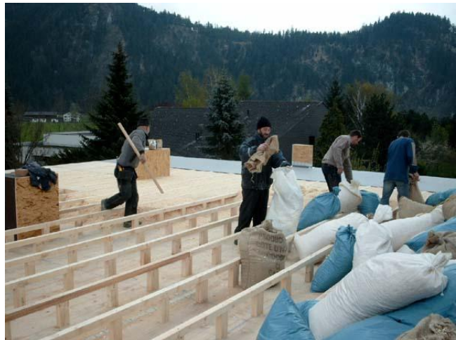
als Isolationsmaterial dienen Schafwolle und Hobelscharten; die Arbeiten werden von TransitarbeiterInnen ausgeführt
