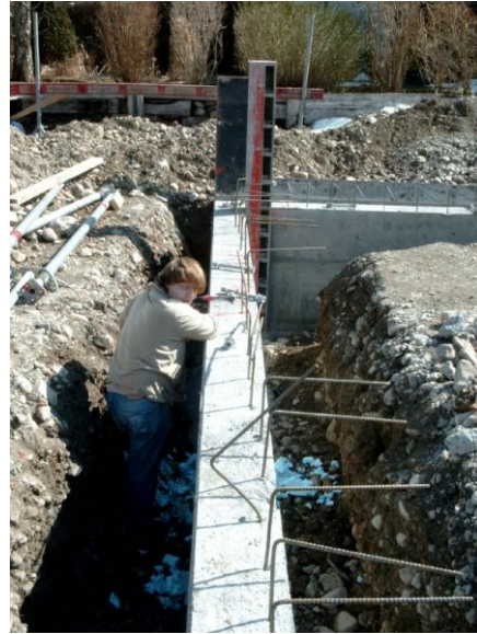
Erdarbeiten und Fundamentlegung
