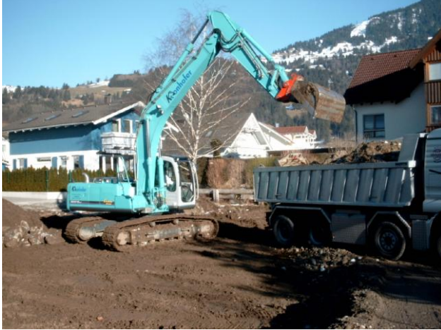
Erdarbeiten und Fundamentlegung
