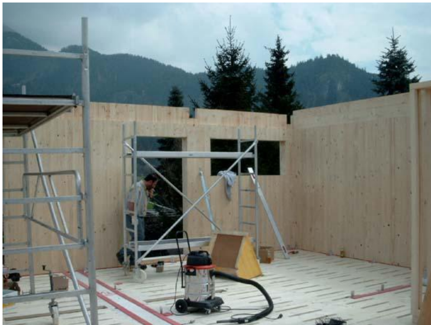
die vorgefertigten Holzelemente werden aufgestellt
