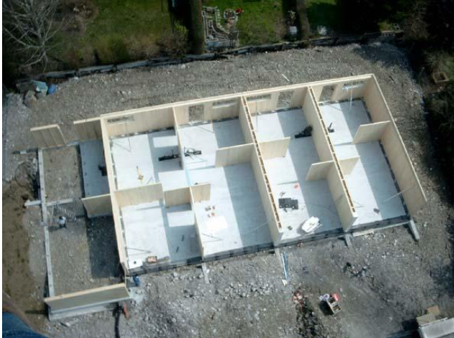
Ansicht des Erdgeschosses aus der Vogelperspektive
